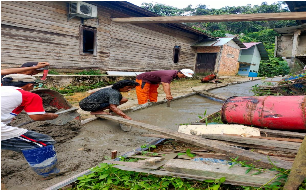
(PENGECORAN JALAN GANG)
