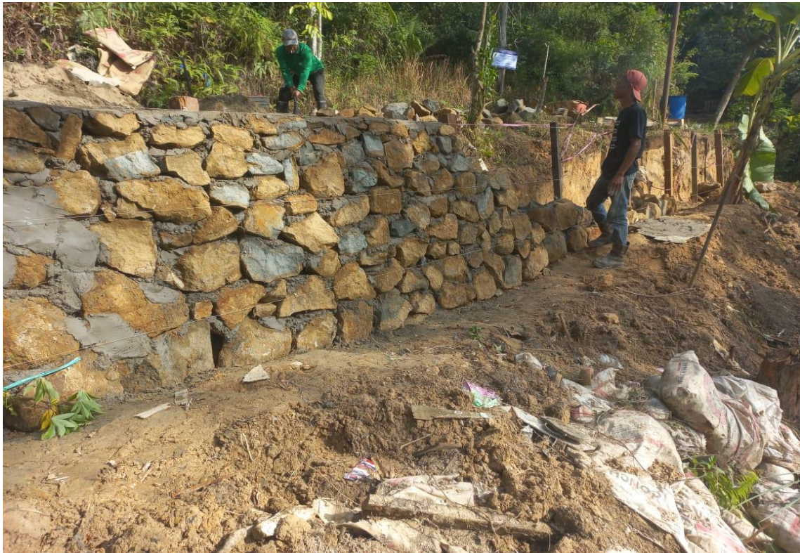
(PEMBUATAN PONDASI/TURAP)
