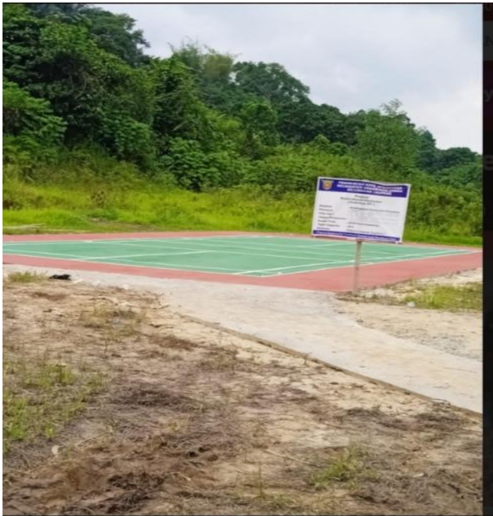
(PEMBANGUNAN SARAN DAN PRASARANA OLAHRAGA)
